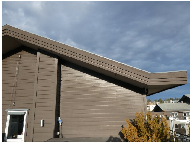
Kledning trenger rengjøring og vask.
