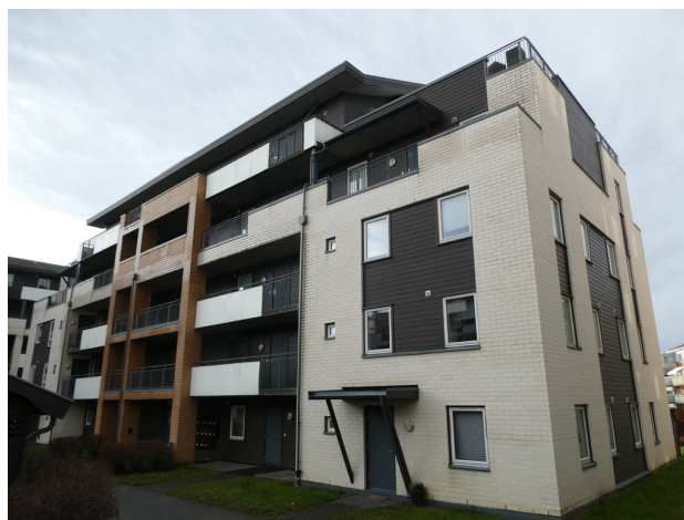
Inngangstak over inngangene til første etasje.
