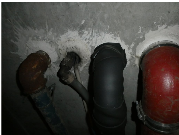
Tett ved gjennomføringer.
