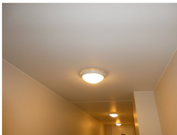
Etasjeskille sett fra korridor.
