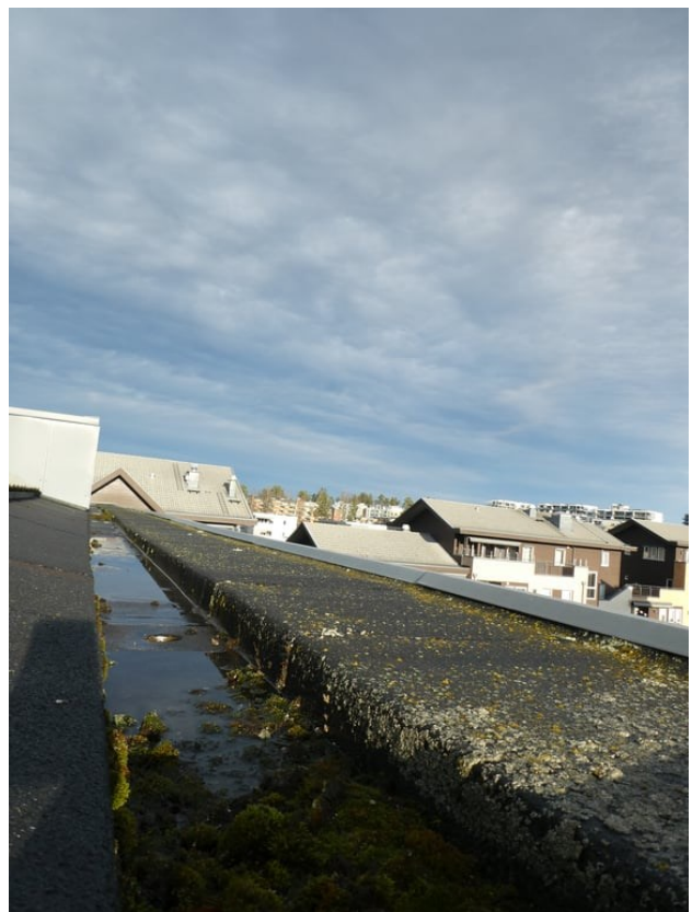
Tekking med asfaltbelegg.
