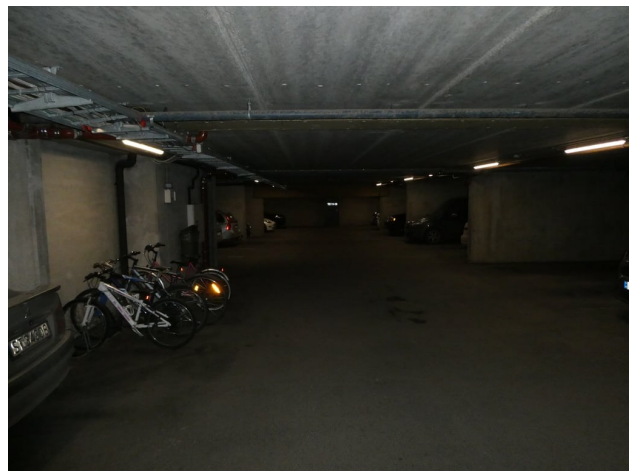
Noe saltutslag på gulv.
