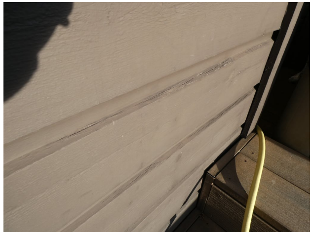
Kledning trenger rengjøring og vask.
