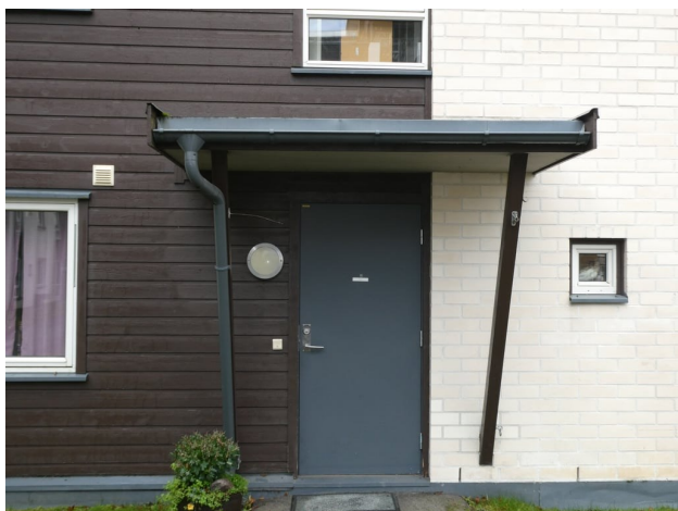
Inngangstak over inngangene til første etasje.
