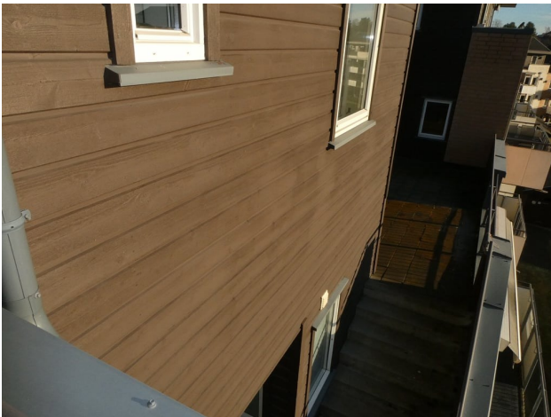
Kledning trenger rengjøring og vask.
