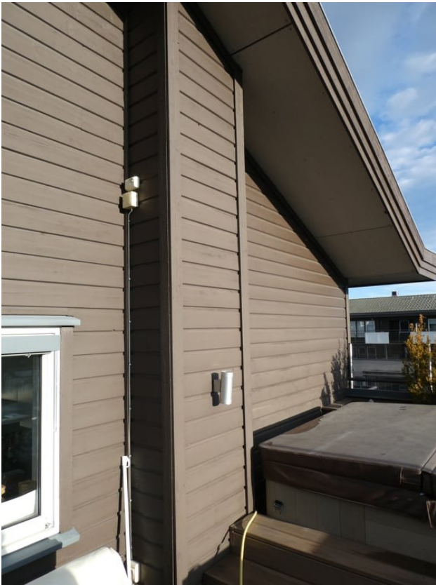
Kledning trenger rengjøring og vask.
