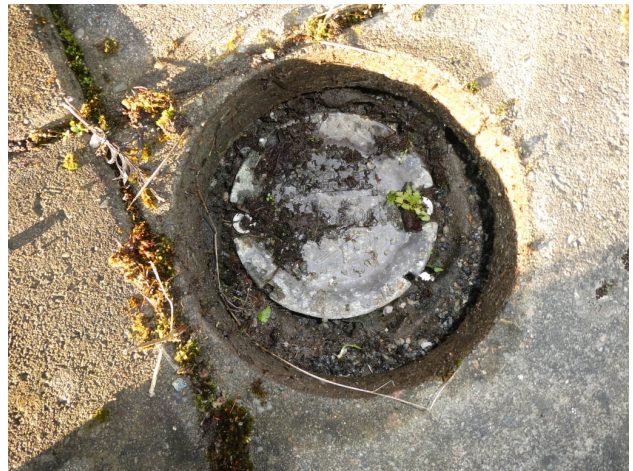
Sluk på felles takterrasse.
