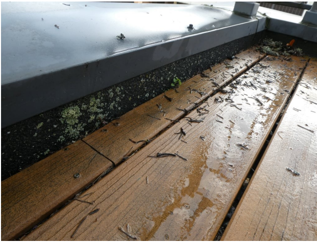
Takterrasse i befart bolig.
