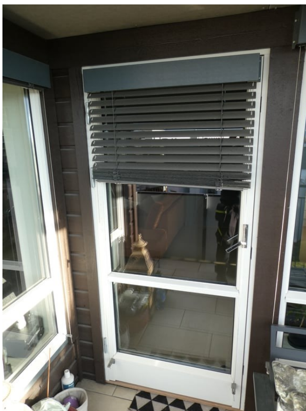
Balkongdør i befart bolig.
