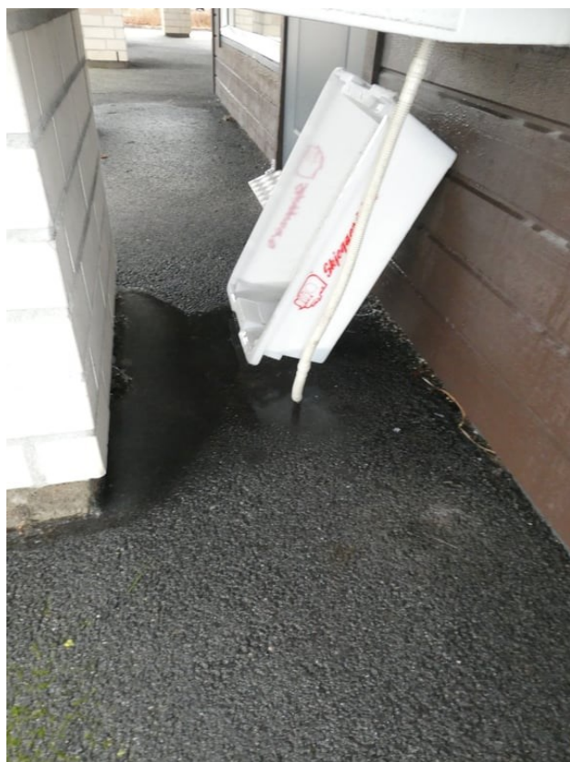
Vannansamling rundt betongsøyle.
