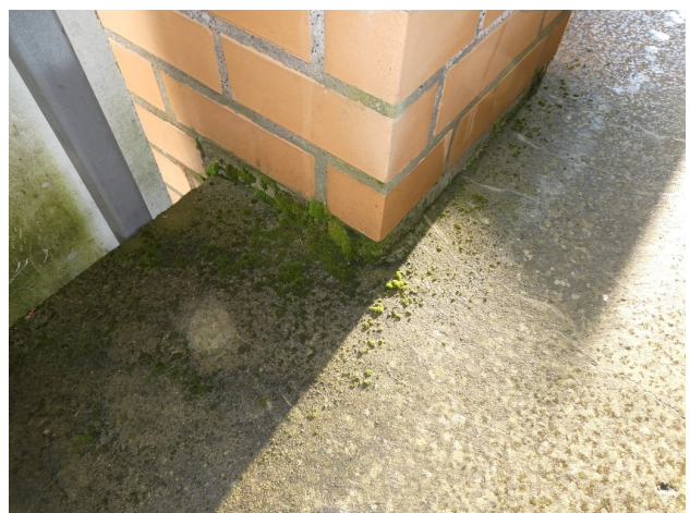
Skitt og smuss på svalganger og dekkekanter.
