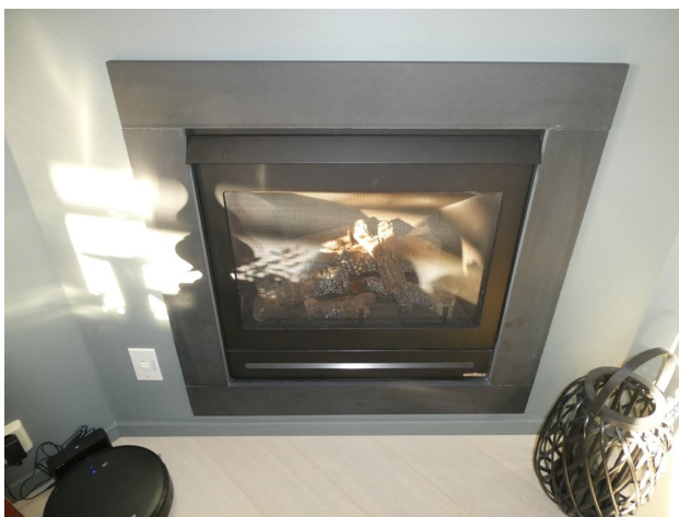
Gasspeis befart i bolig.
