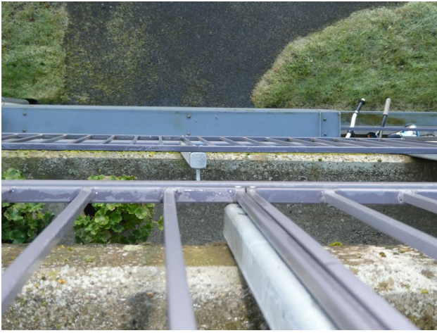
Skitt og smuss på svalganger og dekkekanter.
