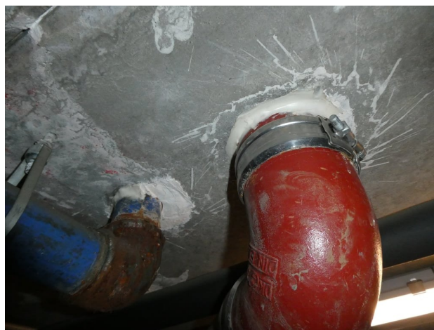
Tett ved gjennomføringer.
