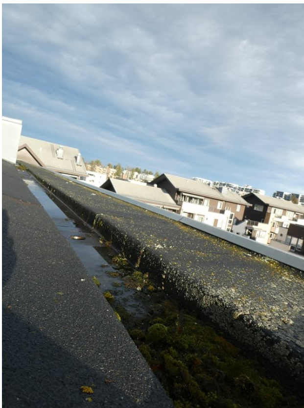
Tekking med asfaltbelegg.
