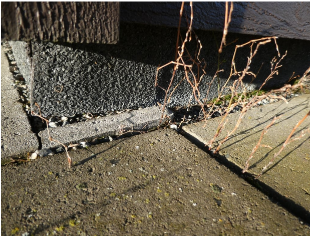
Asfaltbelegg som tekking/membran.
