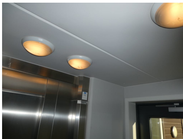
Etasjeskille sett fra trapperom.
