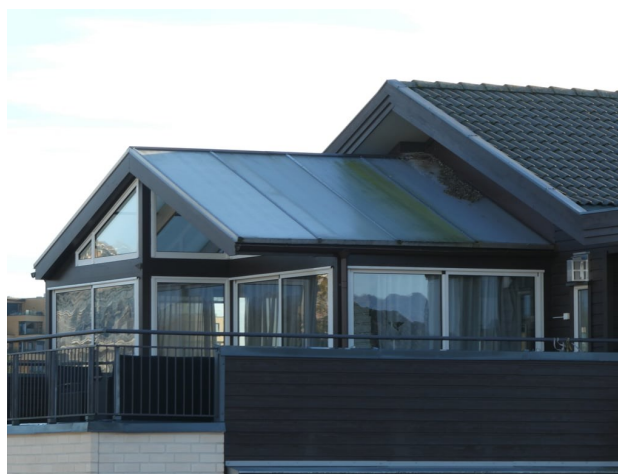
Eksempel ettermontasje i deres sameie.
