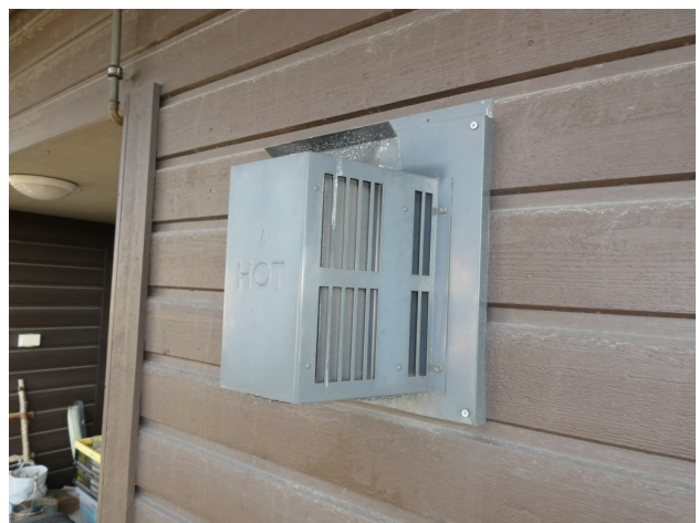
Gasspeis befart i bolig.
