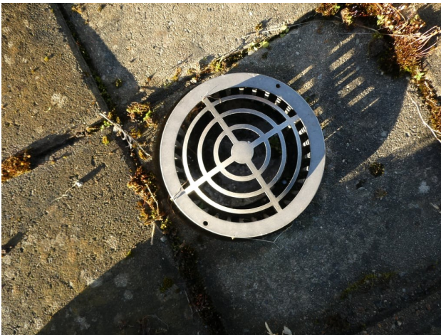
Sluk på felles takterrasse.
