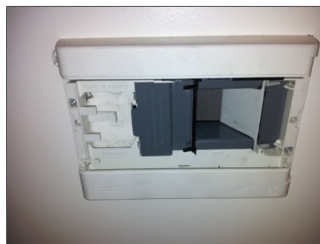
2. Under sitter et spjeld som styres av en fuktindikator som sitter i rammen
