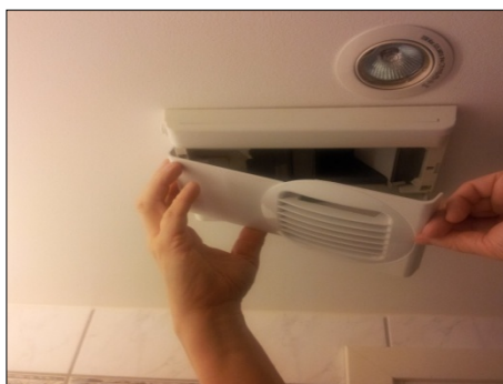
1. Ta ned ventilasjonsdekselet for vask
