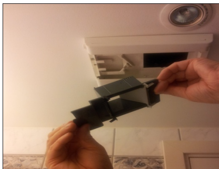
3. Ta ut spjeldet for vask Sett alt tilbake i omvendt rekkefølge
